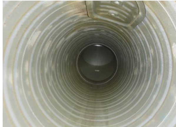
Väljatõmbebetorustik osoonpuhastussüsteemiga
