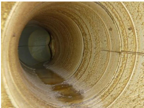
Väljatõmbebetorustik osoonipuhastussüsteemita
