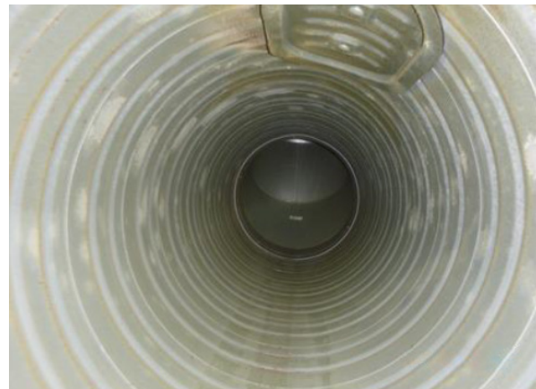
Väljatõmbebetorustik osoonipuhastussüsteemiga
