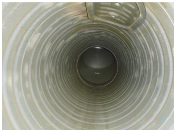
Väljatõmbetorustik osoonpuhastussüsteemiga
