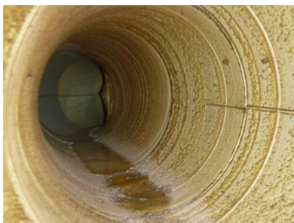
Väljatõmbetorustik osoonpuhastussüsteemita
