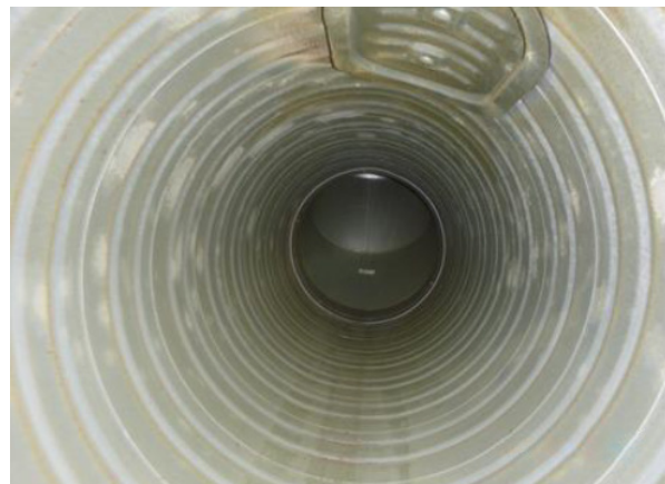
Väljatõmbetorustik osoonpuhastussüsteemiga
